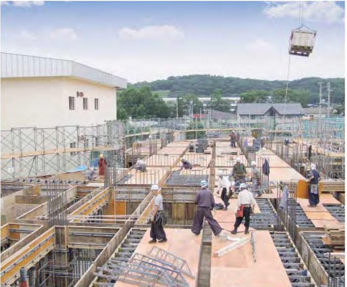
完成待ち遠しい 標茶小学校工事現場
