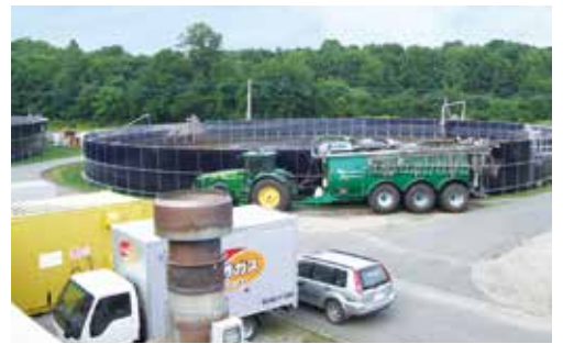
— 鹿追町環境保全センター バイオガスプラント —
