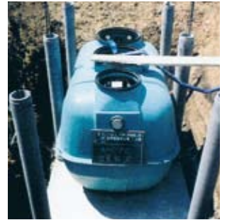
工事中の合併浄化槽
