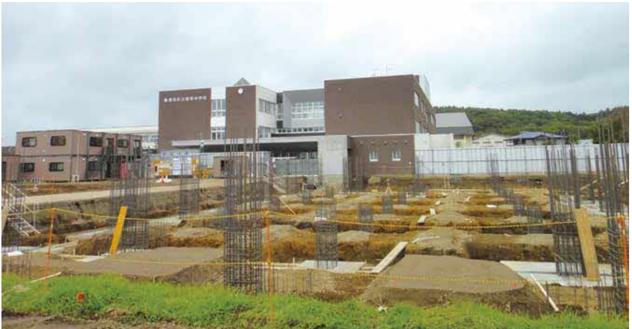
— 標茶中学校 新講堂建設工事の様子 —
