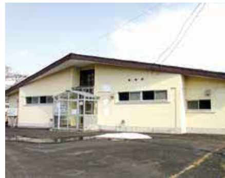
町営水泳プール
