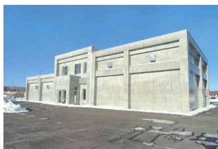
標茶河川防災ステーション
