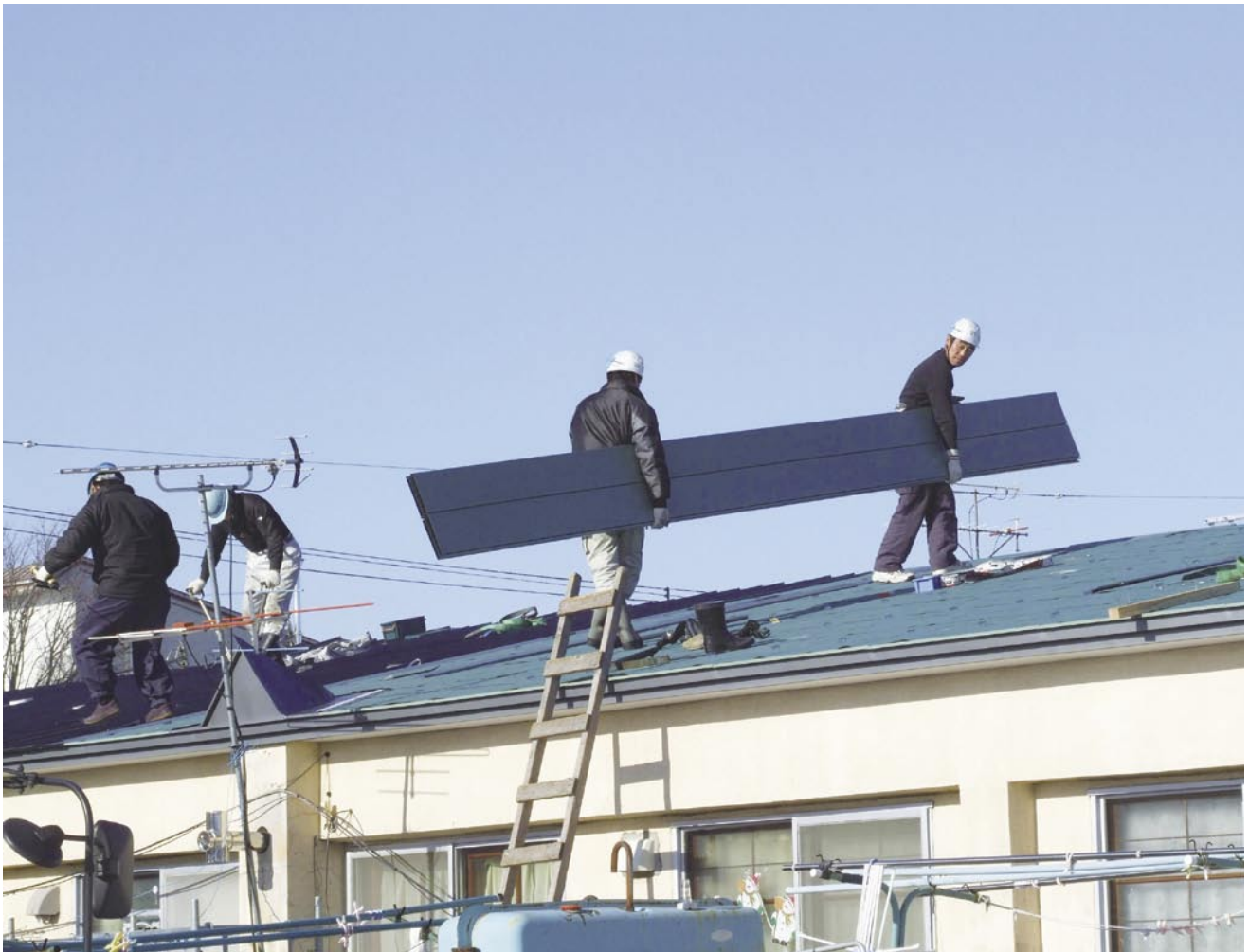
一 町の緊急経済対策……公住の屋根補修 一
