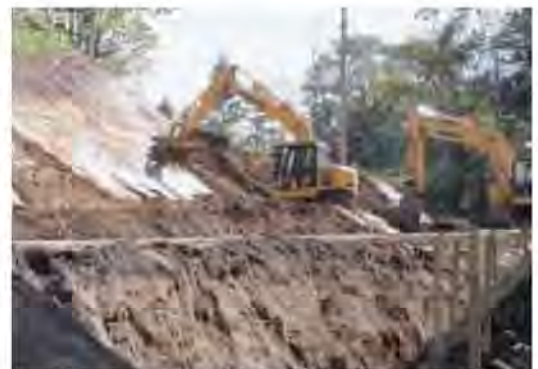
標茶一中茶安別線 道路改良舗装工事
