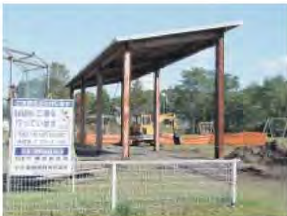
格納施設解体工事
