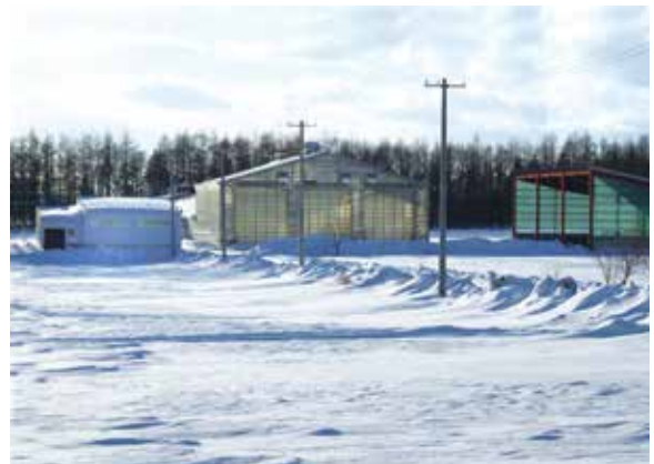
— 磯分内美幌地区堆肥舎 —
