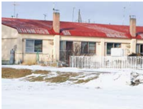
改築が待たれる町営住宅
