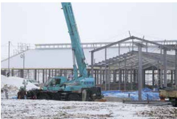
建設が進むTACSしべちゃ
