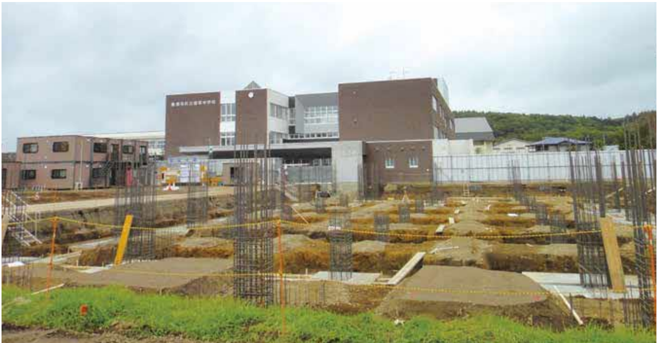
一 標茶中学校 新講堂建設工事の様子 一
