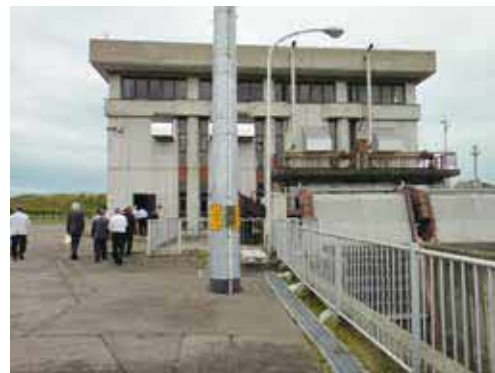
議会視察、池田町の排水機場
