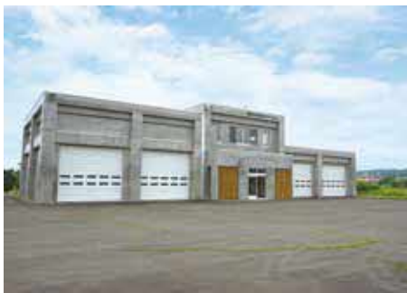
標茶河川防災ステーション
