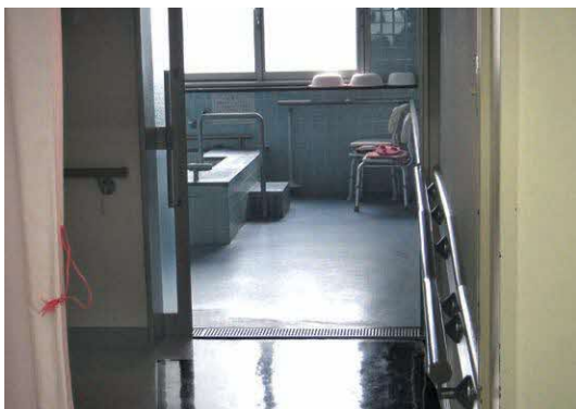
使用停止中の病院浴室
