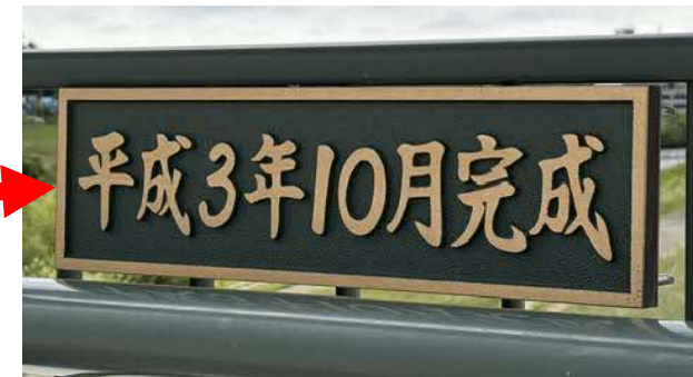
橋名板 (金属製プレート)
