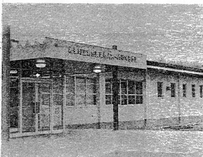
完成した特別養護老人ホーム
