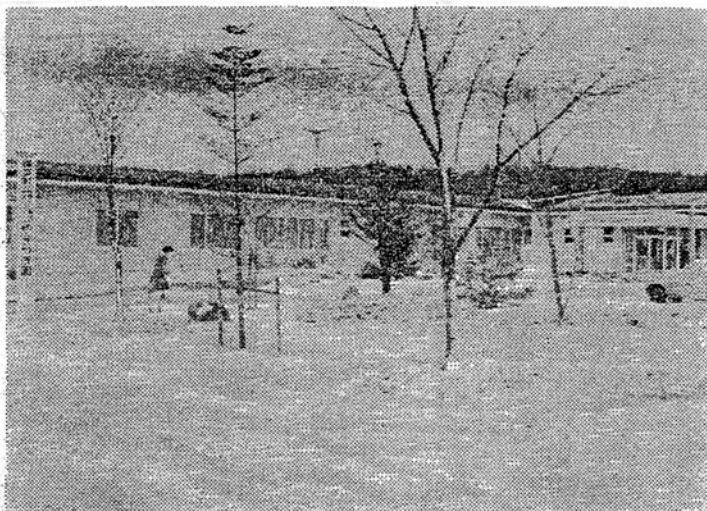
収容定員を倍増した「やすらぎ園」。左側が娯楽室など昨年末完工した新築部分
