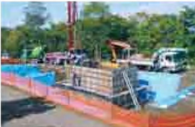
（鉄筋組立型枠設置状況…9月下旬撮影）
