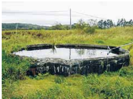
直径3m程の大きな給水施設。写真に写る給水管は、戦後京都大学で設置した。
