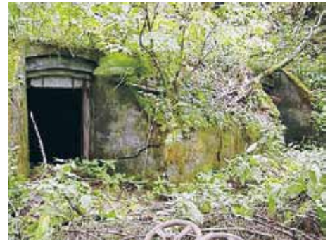
取水場に残されている、コンクリート製のろ過施設2基
