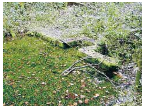
コンクリートで作られた貯水池。凸部分に、取水口がある。
