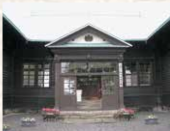
樺戸集治監本庁舎 正門
