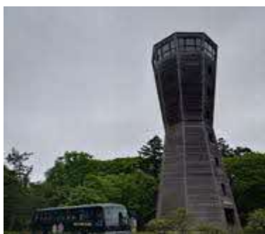
▲樹海観察塔（厚岸町）
