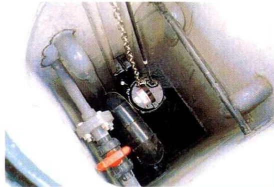
汚泥引抜ポンプ取付工
