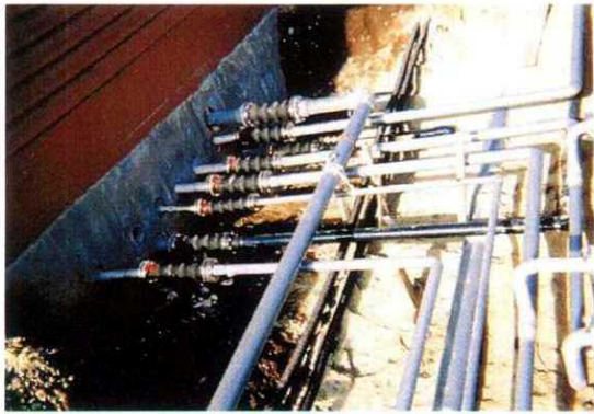
管理棟外部配管工
