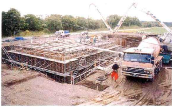
コンクリート打設工
